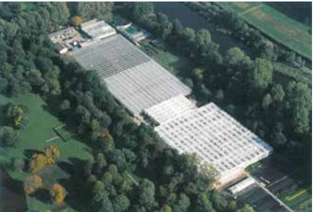
Middelhove met het uitgebreidere kassencomplex.
