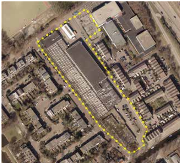
Na alle uitbreidingen aan de Buitenwatersloot is het een hele wandeling van voor- naar achterin het gebouw.
