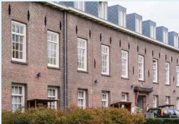
De voormalige kazerne aan de Paardenmarkt na de vernieuwbouw voor Ipse in 2006; alleen de gevel is nog behouden.
