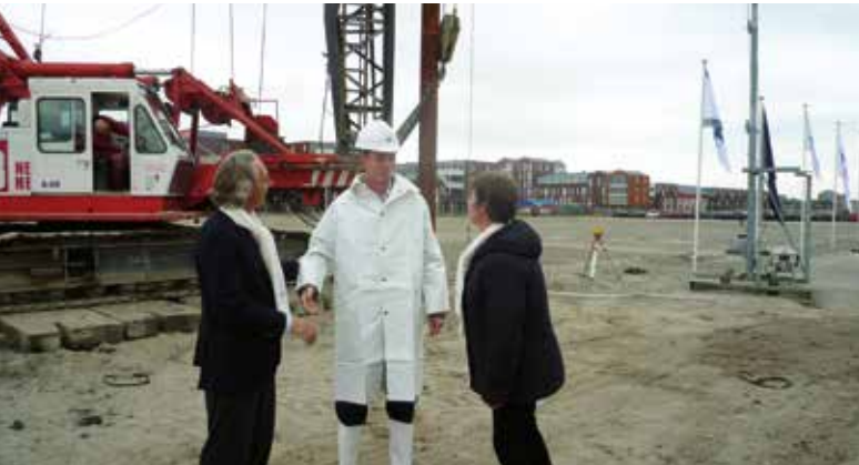
De eerste paal voor de nieuwbouw staat klaar.
