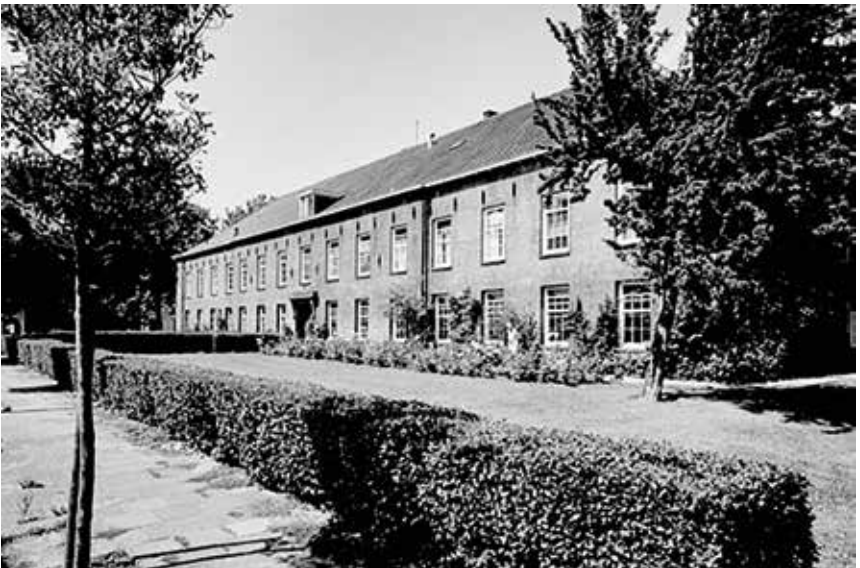
De voormalige kazerne aan de Paardenmarkt in Delft (gebouwd in 1845) is een bijzonder gebouw. In 1923 wordt de kazerne afgekeurd voor de militaire functie. Het gebouw staat in het beschermde stadsgezicht van Delft en is rijksmonument.
